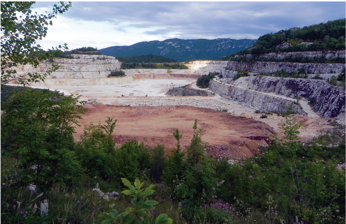
Fig. 20 - Active quarry with overburden and benches, habitat of Blue Rock-Thrush and once of Eastern Black-eared Wheatear. / Cava attiva con riporti di terra e pareti, habitat preferenziale di passero solitario e un tempo di monachella orientale. (Photo: / Foto: M. Gobbini).
