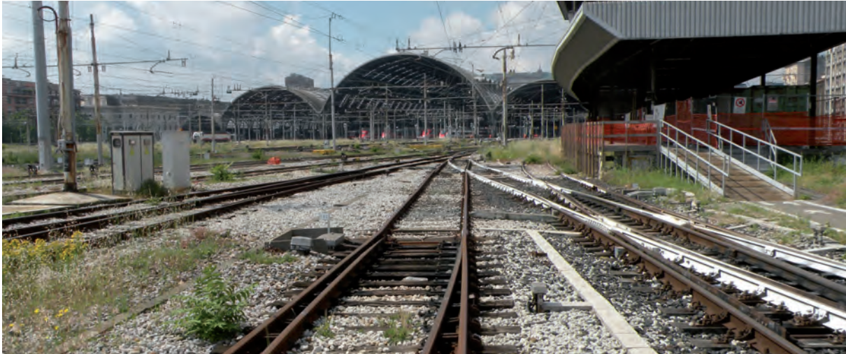
Fig. 1 - Binari nei pressi della Stazione di Milano Centrale. (Foto: Rodolfo Gentili).
