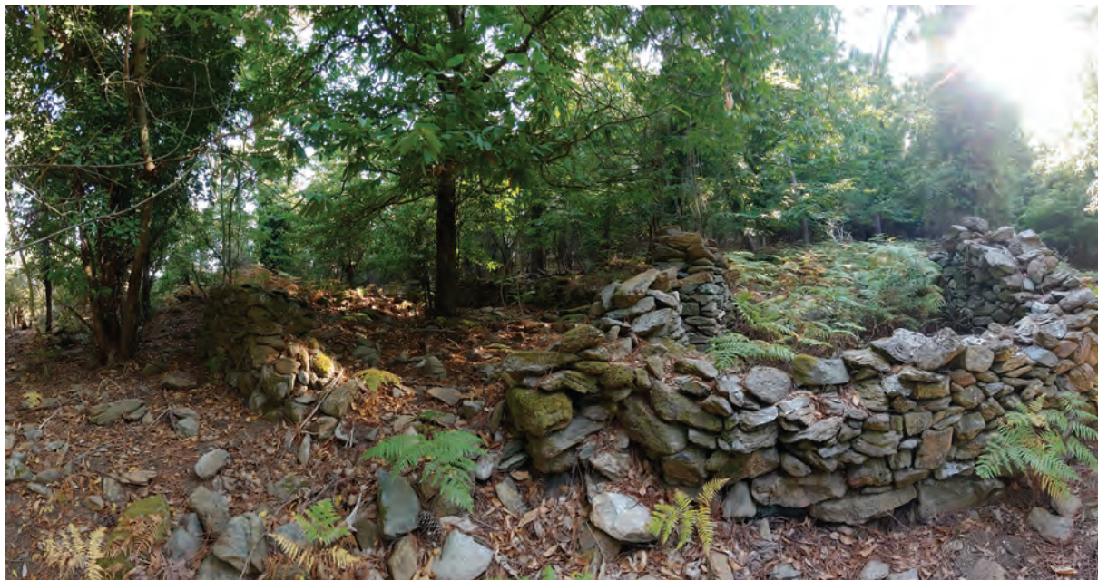
Resti di un antico caprile sul sentiero che conduce da Marciana al Monte Perone per poi passare a San Piero e Sant'Ilario. L'esecuzione dell'opera con spessi muri a secco, e a sacco, ne testimonia una certa antichità tanto da far supporre di potersi trattare del caprile (o, come viene definito, chalet ) notato da Coindet durante la sua visita alle "miniere di rame" sul Perone le quali in effetti si trovano a poche decine di metri da questo manufatto. (Foto di: Ilaria Monti).
