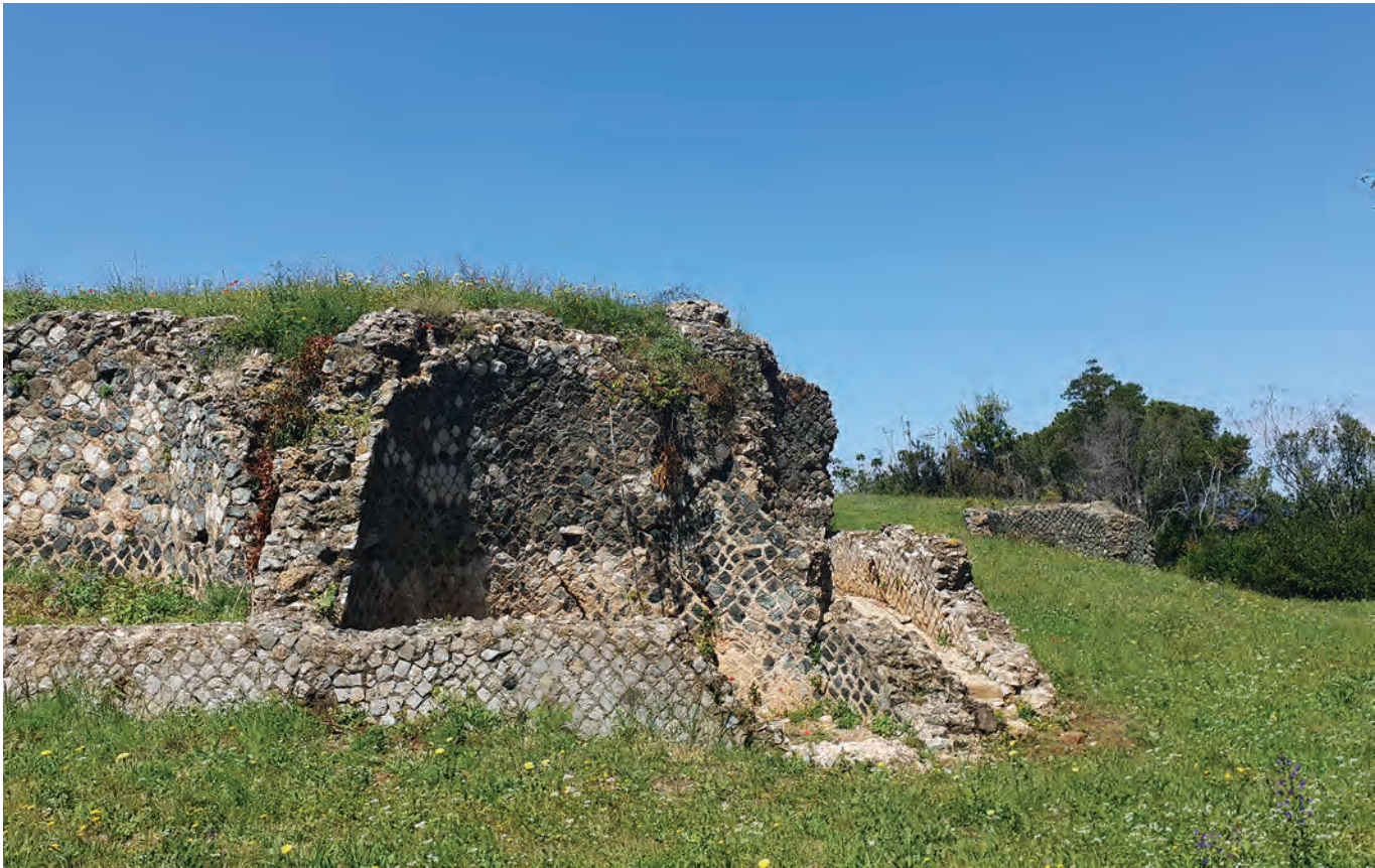
Particolare dell' opus reticulatum della Villa Romana delle Grotte. (Foto di: Ilaria Monti).
