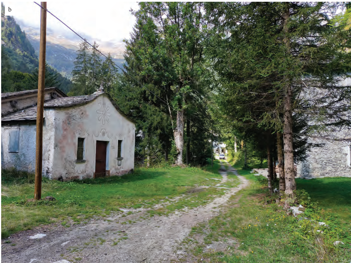
Fig. 27 - Stazione 11. a) Area antistante l'edificio termale. b) Area circostante la Chiesetta dei Bagni. / Station 11. a) Area in front of the thermal building. b) Area surrounding the little Church of Bagni. (Photos: F. Penati).
