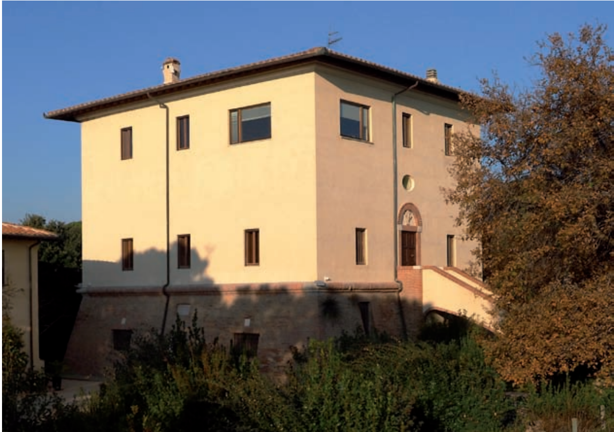
Fig. 8 - Torre Trappola recentemente restaurata / Torre Trappola recently restored (Foto / Photo Stefano Laurenti).
